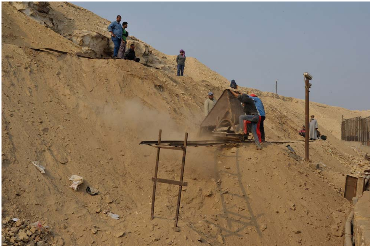
Илл. 2. Процесс работ на Участке III
